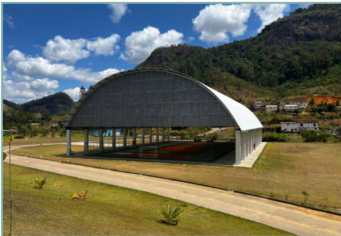
IMAGEM 7.24 - GINÁSIO DO CAMPUS CENTRO SERRANO EM FASE FINAL DE EXECUÇÃO
