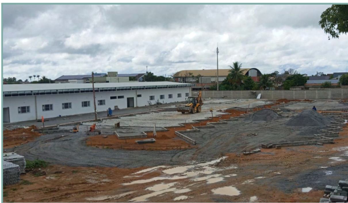
IMAGEM 7.21 - OBRA DE IMPLANTAÇÃO DO CAMPUS PEDRO CANÁRIO (DEZEMBRO DE 2024)
