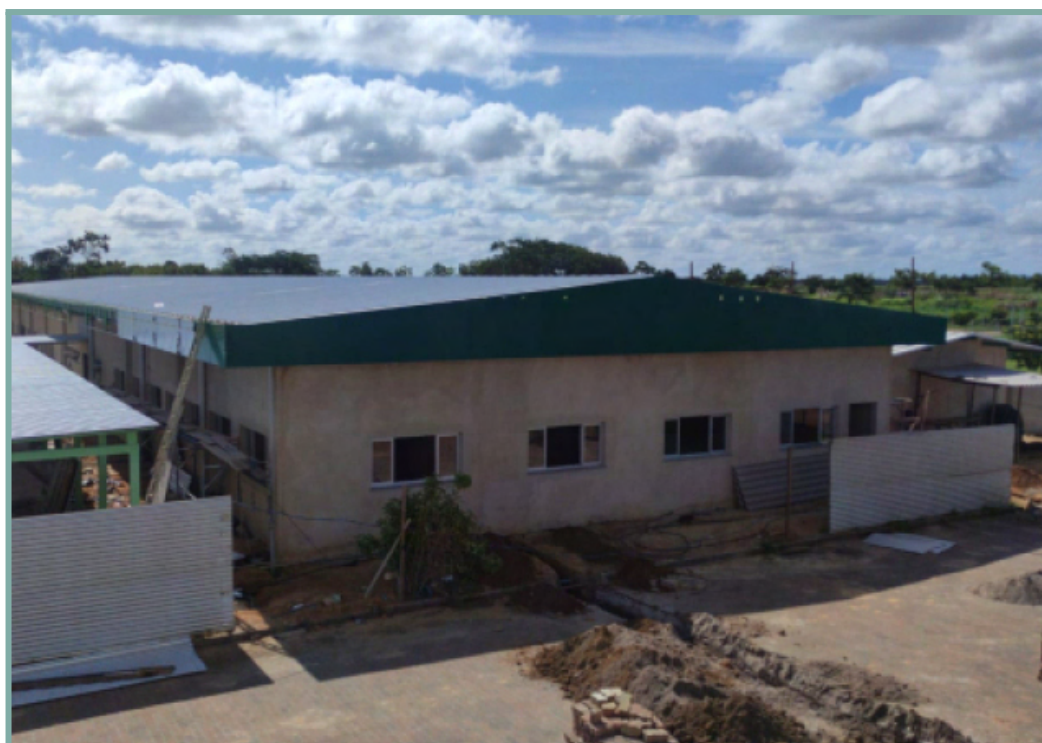
IMAGEM 7.25 - CONSTRUÇÃO DO BLOCO C NO CAMPUS MONTANHA
