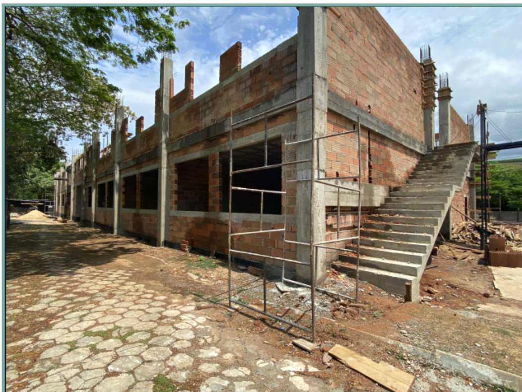
IMAGEM 7.26 - CONSTRUÇÃO DO BLOCO ACADÊMICO Nº 3 NO CAMPUS NOVA VENÉCIA
