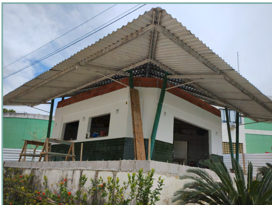
IMAGEM 7.27 - REFORMA DO CRA NO CAMPUS LINHARES
